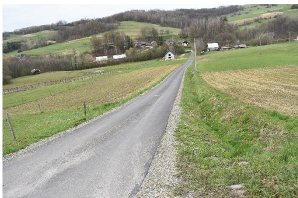
Nowa nawierzchnia w Pietruszej Woli
