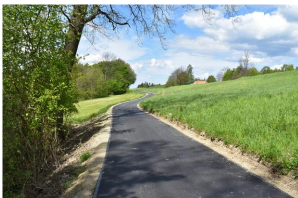
Nowa nawierzchnia w Odrzykoń
