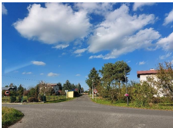
Nowe oświetlenie w Bajdach
