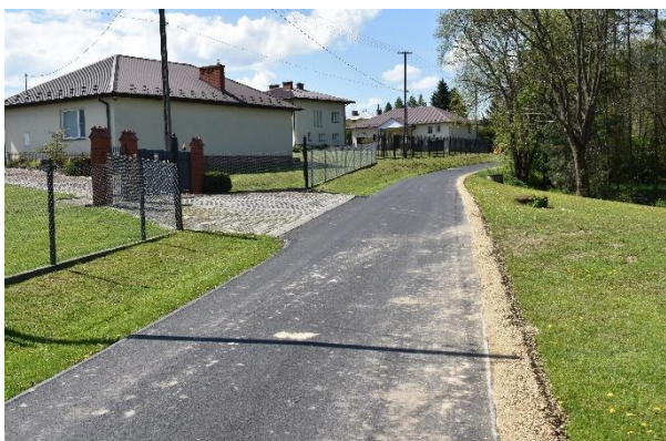
Nowa nawierzchnia w Ustrobnej
