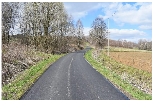
Nowa nawierzchnia w Pietruszej Woli
