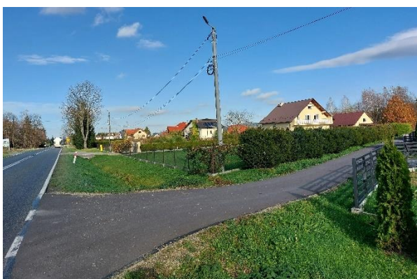
Nowa nawierzchnia w Bajdach
