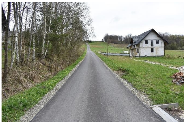
Nowa nawierzchnia w Pietruszej Woli
