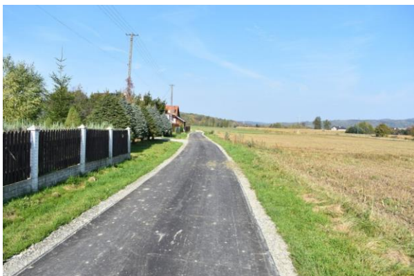
Nowa nawierzchnia w Przybówce
