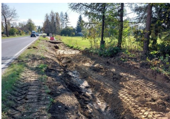
Budowa chodnika w Wojaszówce
