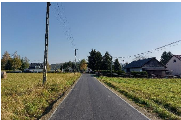
Nowa nawierzchnia w Odrzykoniu
