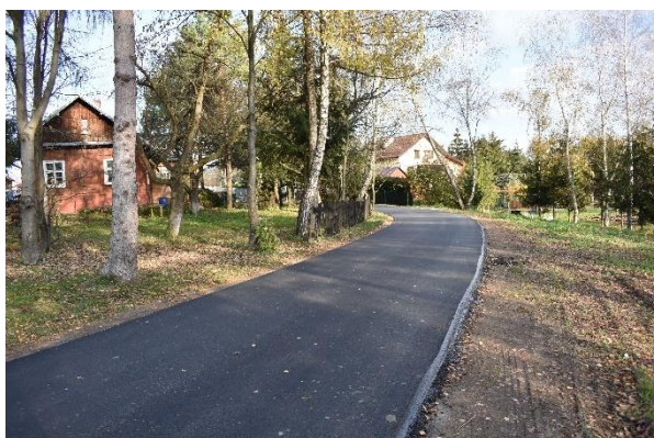
Nowa nawierzchnia w Odrzykoniu
