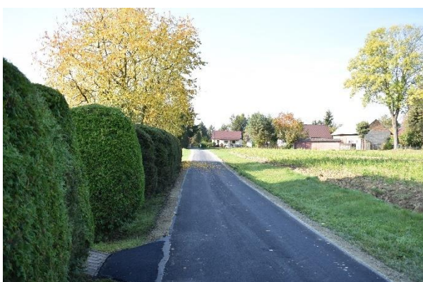
Nowa nawierzchnia w Bratkówce
