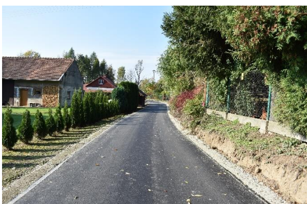
Nowa nawierzchnia w Bratkówce
