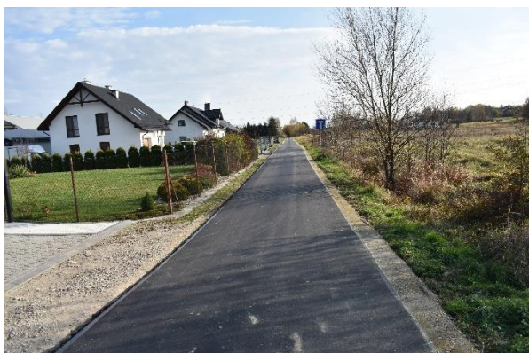
Nowa nawierzchnia w Odrzykoniu
