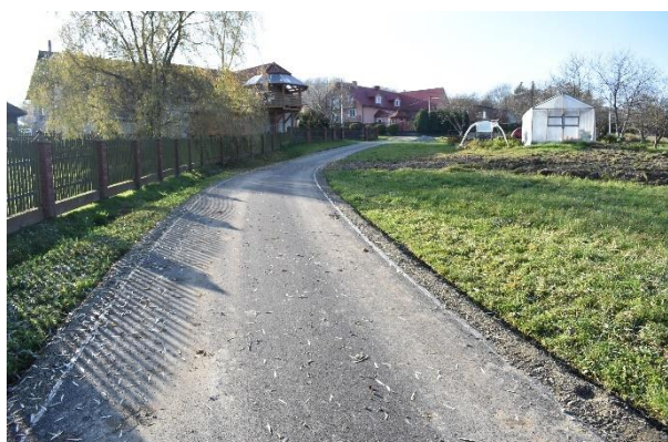
Nowa nawierzchnia w Rzepniku
