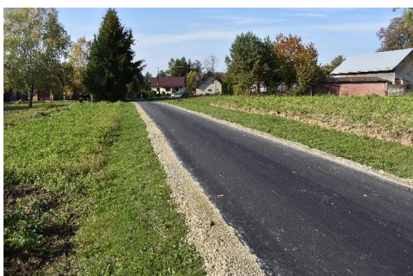
Nowa nawierzchnia w Bratkówce
