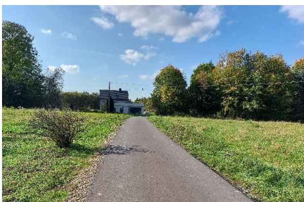
Nowa nawierzchnia w Bajdach
