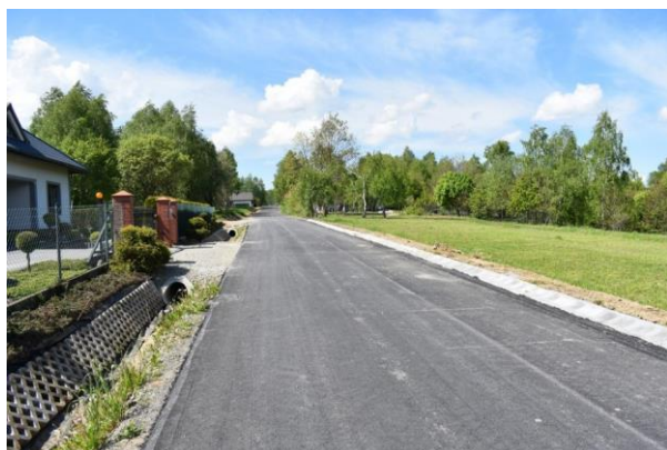
Nowa nawierzchnia w Ustrobnej
