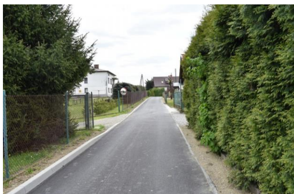
Nowa nawierzchnia w Odrzykoń
