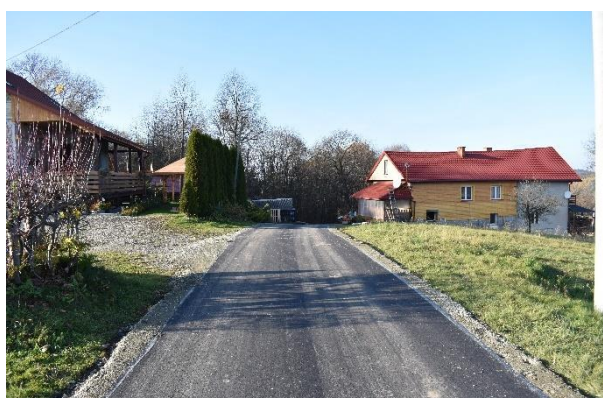
Nowa nawierzchnia w Rzepniku
