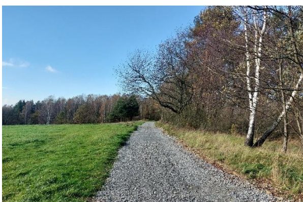
Nowa nawierzchnia w Rzepniku
