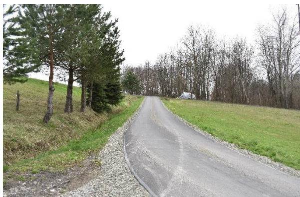
Nowa nawierzchnia w Pietruszej Woli
