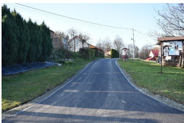
Nowa nawierzchnia w Rzepniku
