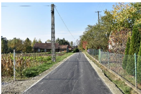
Nowa nawierzchnia w Bratkówce
