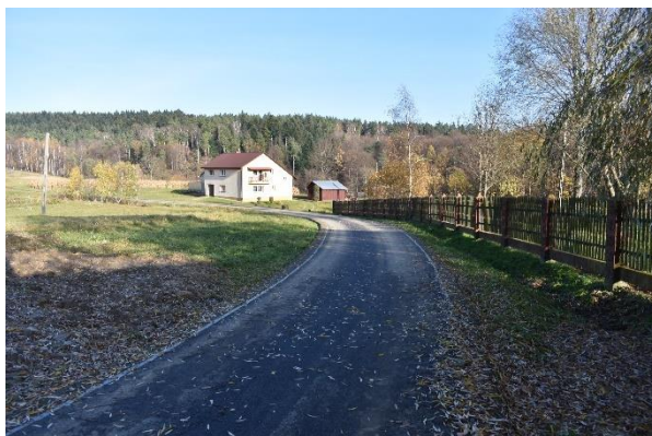
Nowa nawierzchnia w Rzepniku
