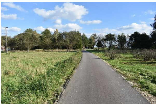
Nowa nawierzchnia w Bajdach
