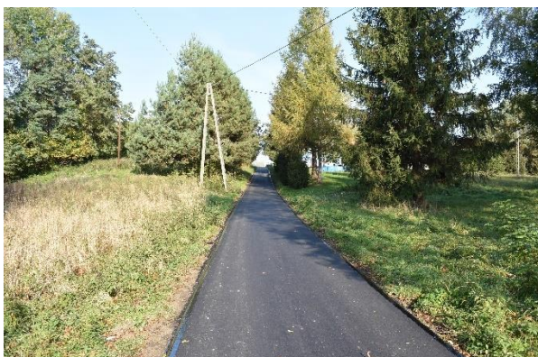
Nowa nawierzchnia w Odrzykoń
