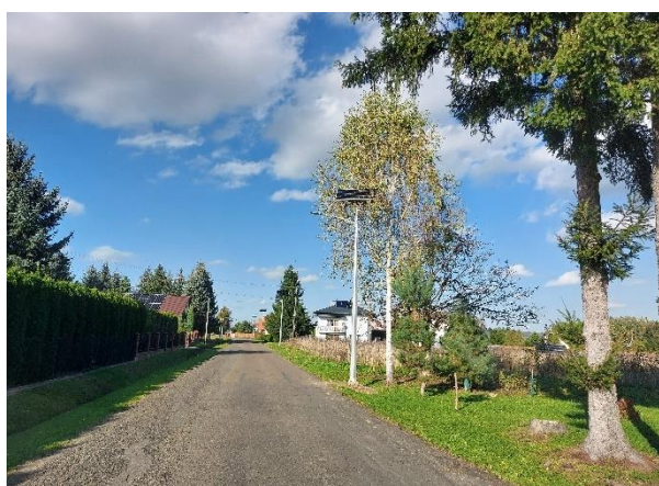
Nowe oświetlenie w Bajdach
