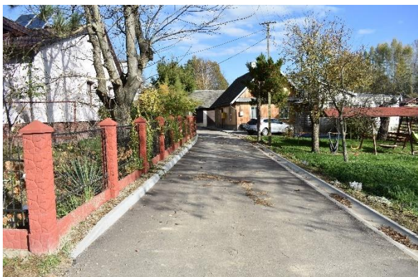
Nowa nawierzchnia w Bratkówce
