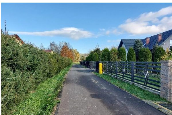
Nowa nawierzchnia w Bajdach
