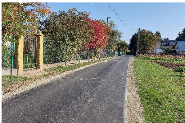
Nowa nawierzchnia w Bratkówce
