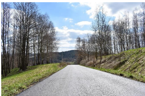
Nowa nawierzchnia w Pietruszej Woli
