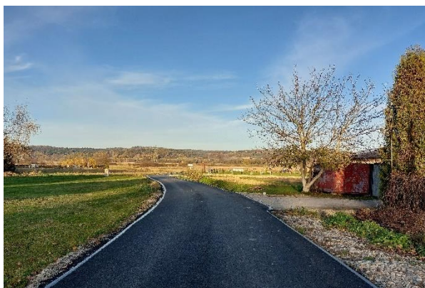
Nowa nawierzchnia w Ustrobnej
