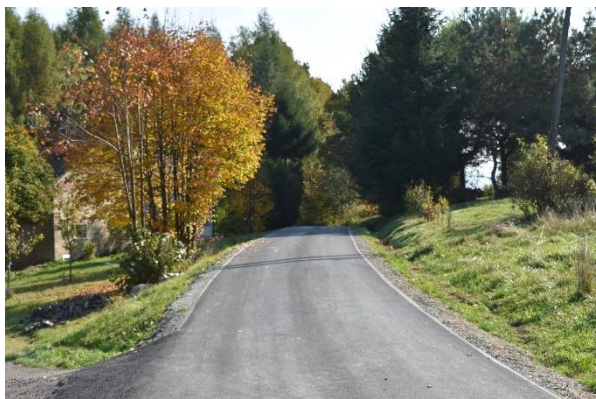
Nowa nawierzchnia w Przybówce
