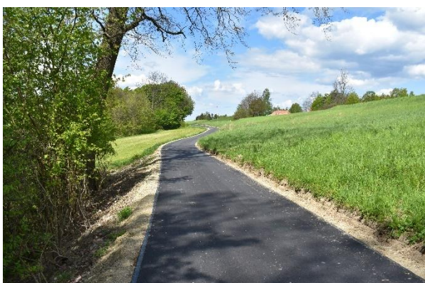
Nowa nawierzchnia w Odrzykoniu
