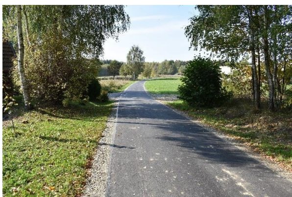
Nowa nawierzchnia w Przybówce
