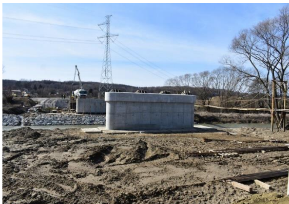
Budowa mostu w Łękach Strzyżowskich
