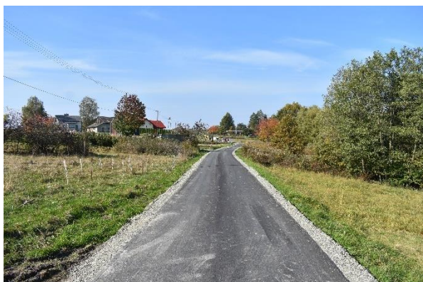
Nowa nawierzchnia w Przybówce
