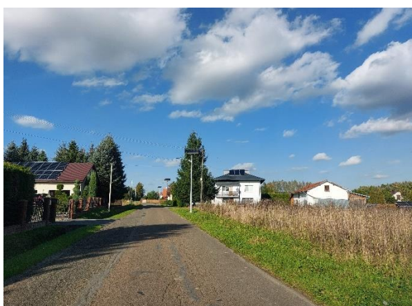
Nowe oświetlenie w Bajdach
