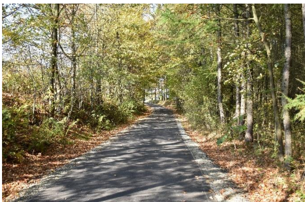
Nowa nawierzchnia w Przybówce
