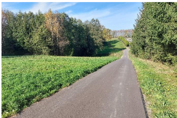
Nowa nawierzchnia w Ustrobnej
