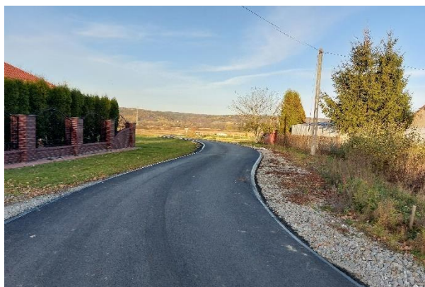
Nowa nawierzchnia w Ustrobnej
