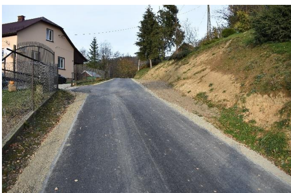
Nowa nawierzchnia w Odrzykoniu
