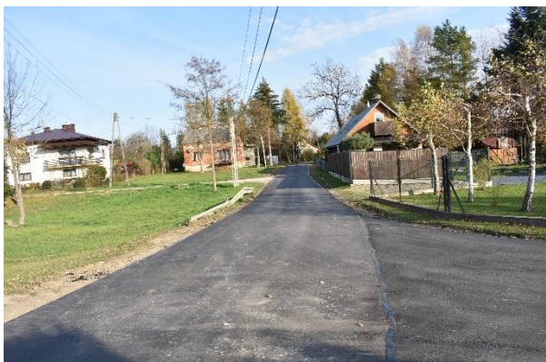
Nowa nawierzchnia w Odrzykoniu
