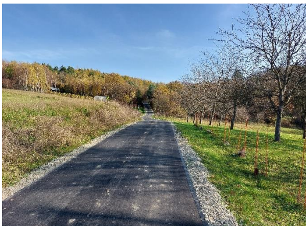
Nowa nawierzchnia w Wojkówce
