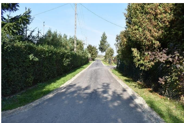
Nowa nawierzchnia w Przybówce
