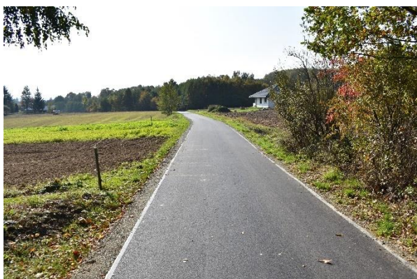
Nowa nawierzchnia w Przybówce
