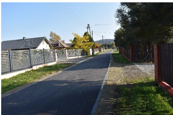
Nowa nawierzchnia w Odrzykoniu
