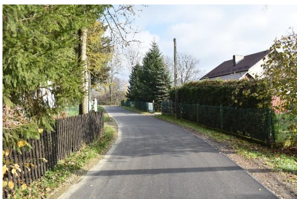
Nowa nawierzchnia w Odrzykoniu
