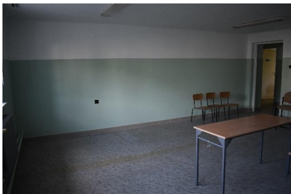
Remont w SP w Wojaszówce
