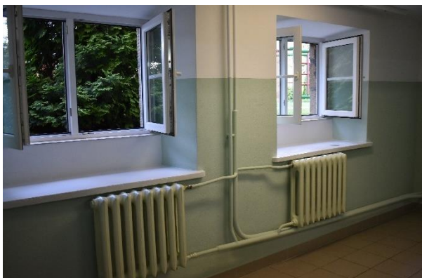
Remont w SP w Wojaszówce
