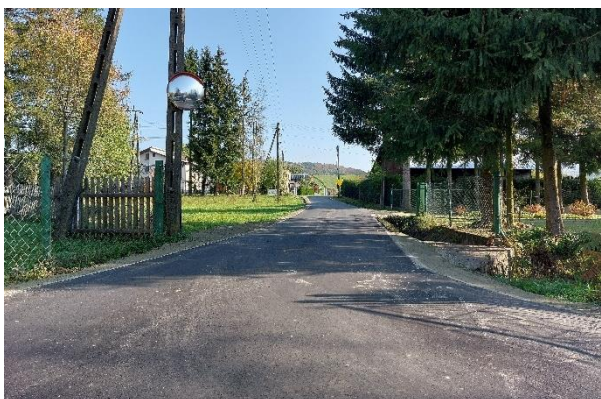
Nowa nawierzchnia w Bratkówce
