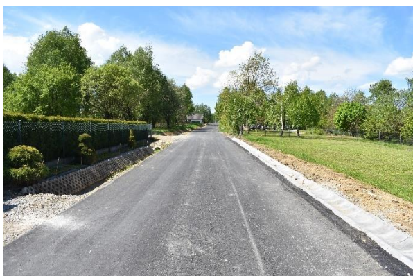
Nowa nawierzchnia w Ustrobnej
