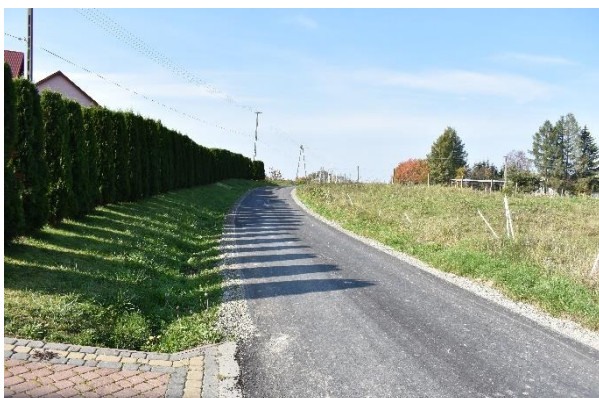
Nowa nawierzchnia w Przybówce
