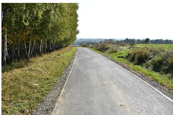
Nowa nawierzchnia w Przybówce
