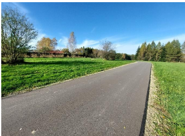
Nowa nawierzchnia w Ustrobnej
