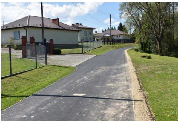
Nowa nawierzchnia w Ustrobnej
