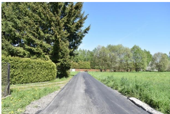
Nowa nawierzchnia w Bajdach
