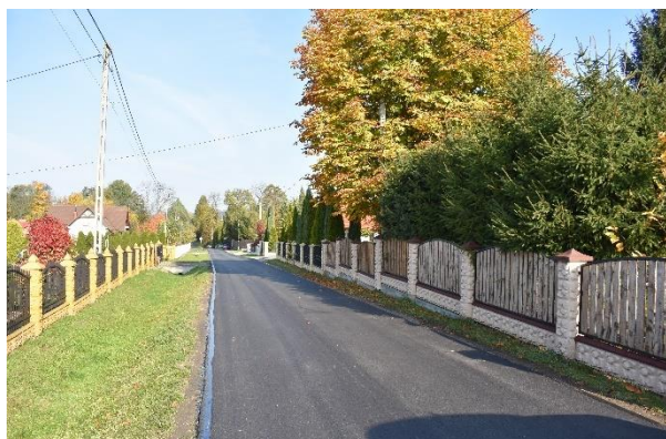
Nowa nawierzchnia w Odrzykoń
