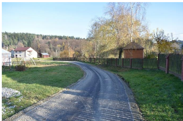
Nowa nawierzchnia w Rzepniku
