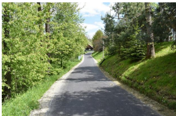
Nowa nawierzchnia w Odrzykoń
