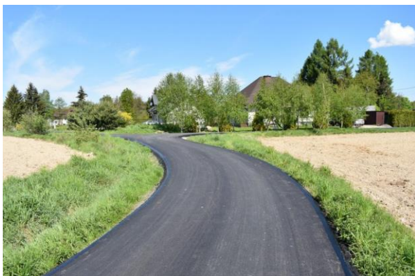
Nowa nawierzchnia w Bajdach
