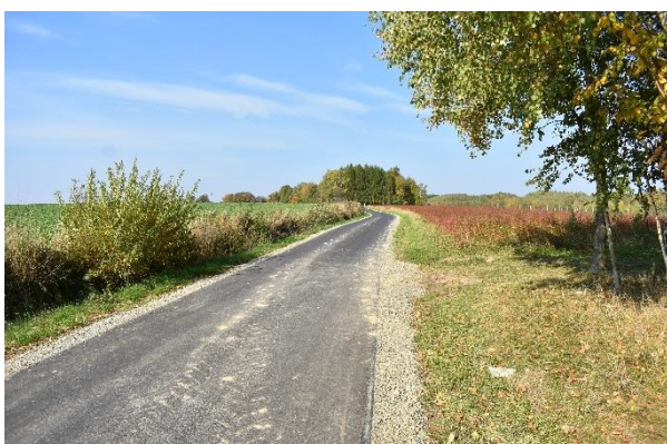
Nowa nawierzchnia w Przybówce
