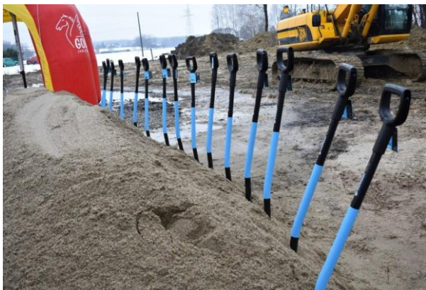
Rozpoczęcie budowy mostu w Odrzykoniu
