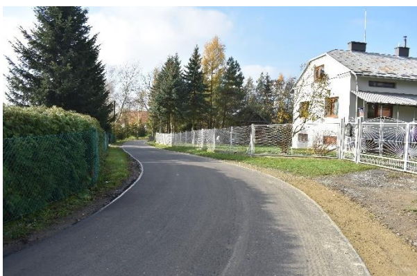
Nowa nawierzchnia w Odrzykoniu
