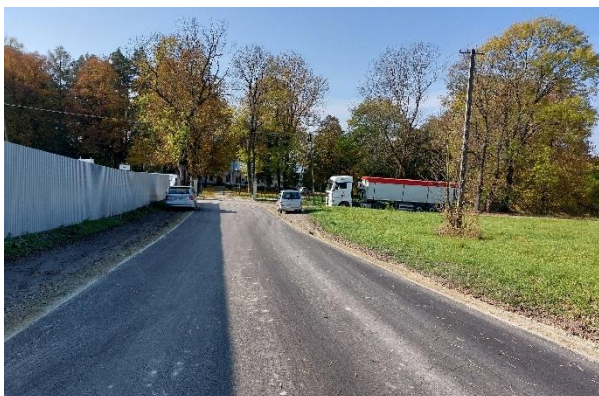
Nowa nawierzchnia w Bratkówce
