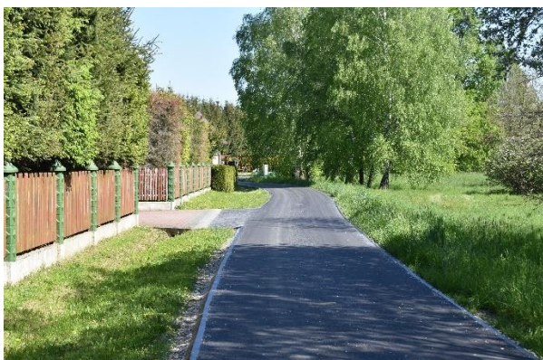
Nowa nawierzchnia w Bajdach
