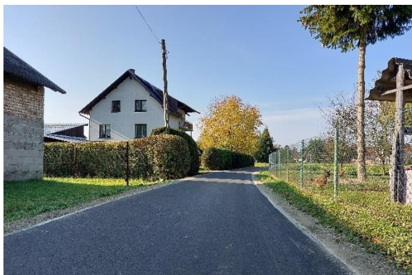
Nowa nawierzchnia w Bratkówce
