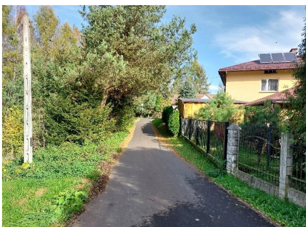
Nowa nawierzchnia w Ustrobnej
