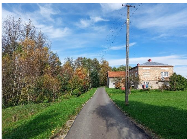
Nowa nawierzchnia w Ustrobnej
