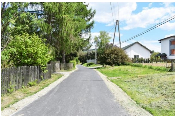
Nowa nawierzchnia w Odrzykoń
