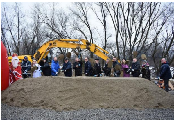
Rozpoczęcie budowy mostu w Odrzykoniu
