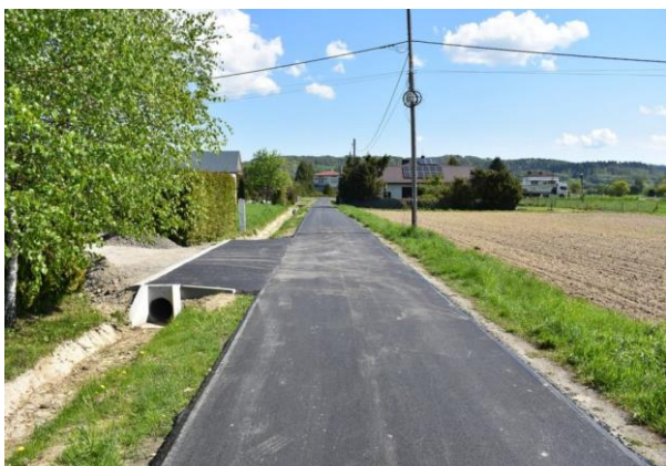
Nowa nawierzchnia w Bajdach
