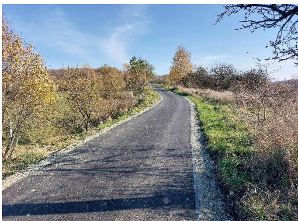
Nowa nawierzchnia w Wojkówce
