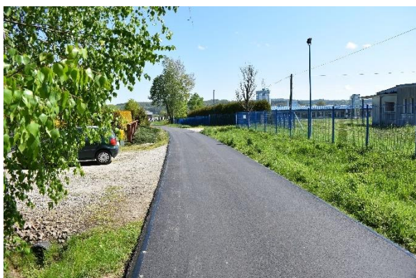
Nowa nawierzchnia w Bajdach
