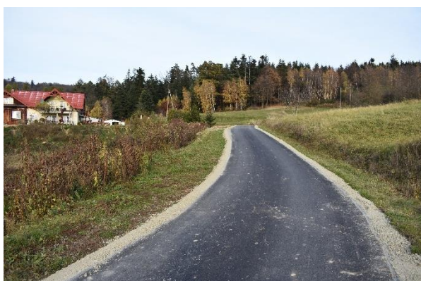
Nowa nawierzchnia w Odrzykoniu
