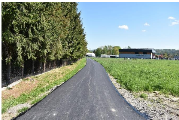
Nowa nawierzchnia w Bajdach
