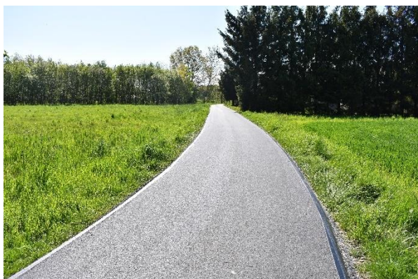
Nowa nawierzchnia w Bajdach
