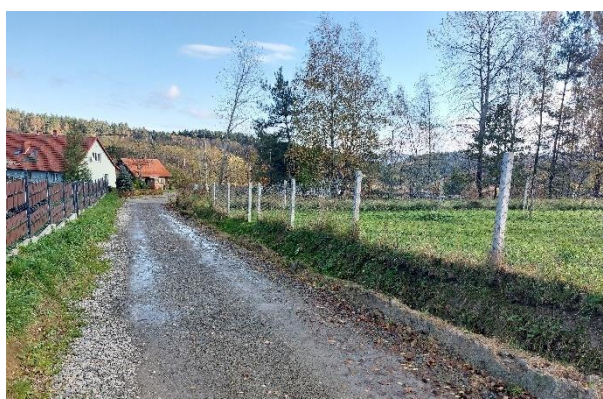
Nowa nawierzchnia w Rzepniku
