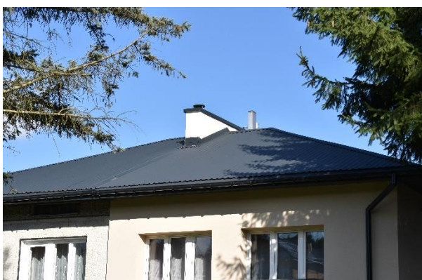
Termomodernizacja w Ustrobnej
