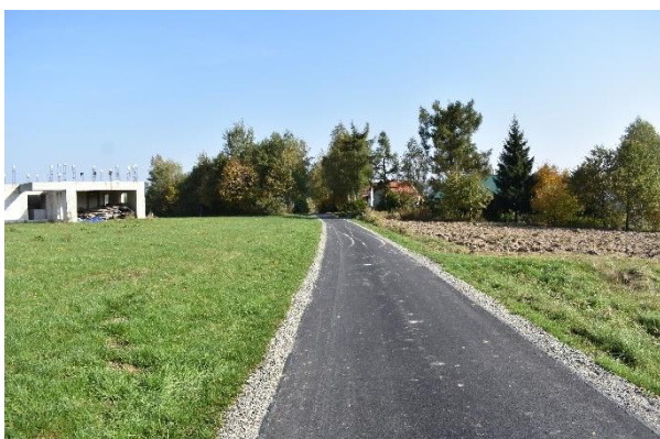
Nowa nawierzchnia w Przybówce
