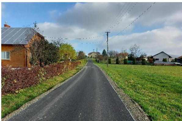
Nowa nawierzchnia w Odrzykoniu
