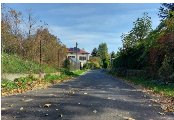
Nowa nawierzchnia w Wojaszówce
