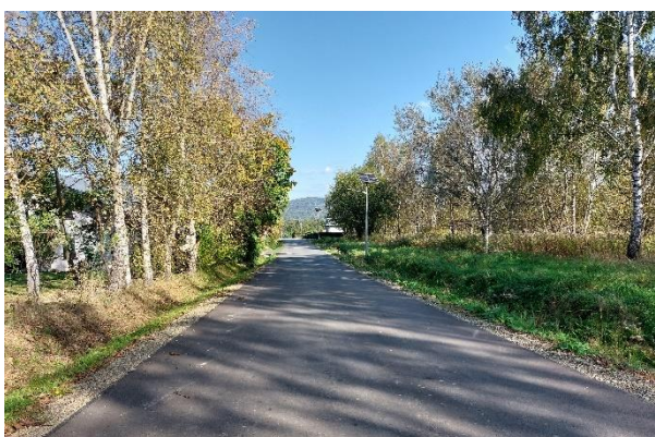
Nowa nawierzchnia w Ustrobnej
