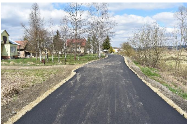
Nowa nawierzchnia w Odrzykoniu
