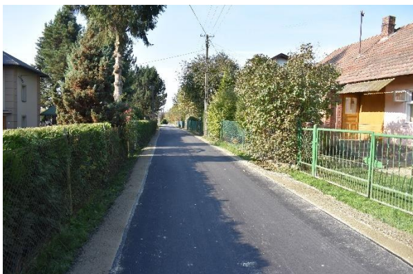
Nowa nawierzchnia w Bratkówce
