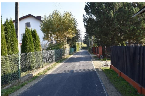
Nowa nawierzchnia w Bratkówce
