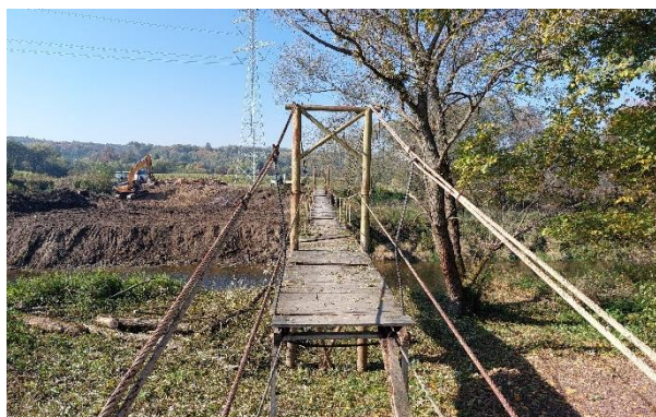
Budowa mostu w Łękach Strzyżowskich
