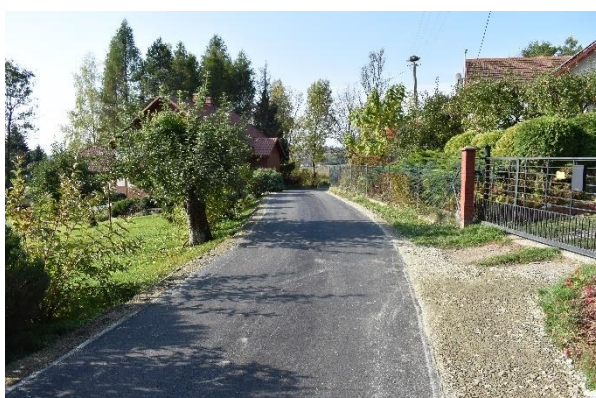
Nowa nawierzchnia w Bratkówce
