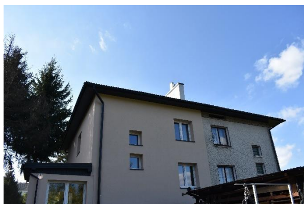
Termomodernizacja w Ustrobnej
