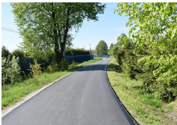
Nowa nawierzchnia w Bajdach
