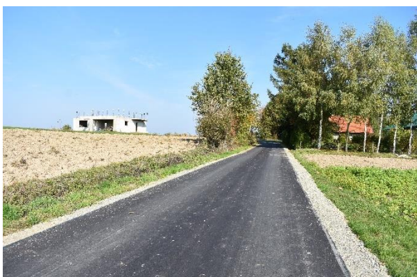
Nowa nawierzchnia w Przybówce
