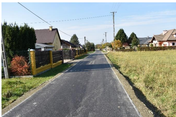
Nowa nawierzchnia w Odrzykoniu
