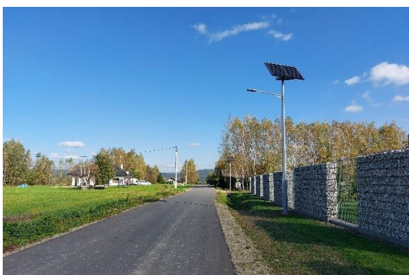
Nowa nawierzchnia w Ustrobnej
