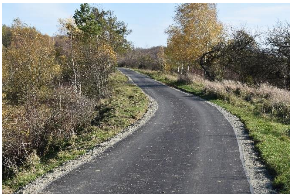
Nowa nawierzchnia w Wojkówce
