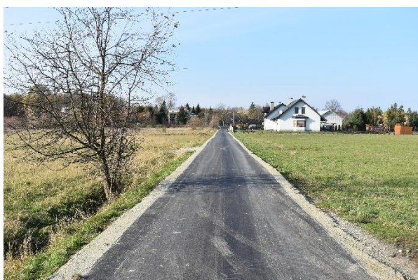
Nowa nawierzchnia w Odrzykoniu
