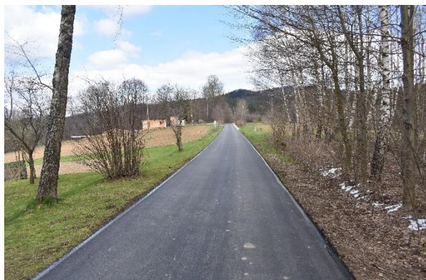
Nowa nawierzchnia w Pietruszej Woli
