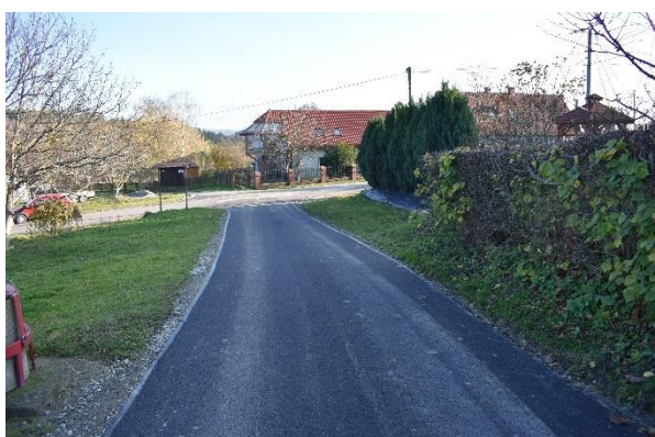
Nowa nawierzchnia w Rzepniku
