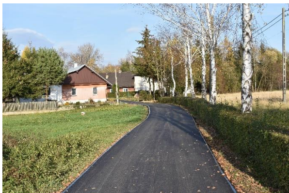
Nowa nawierzchnia w Odrzykoniu
