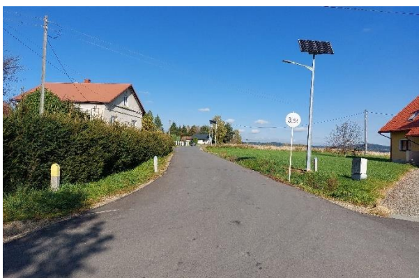
Nowa nawierzchnia w Ustrobnej
