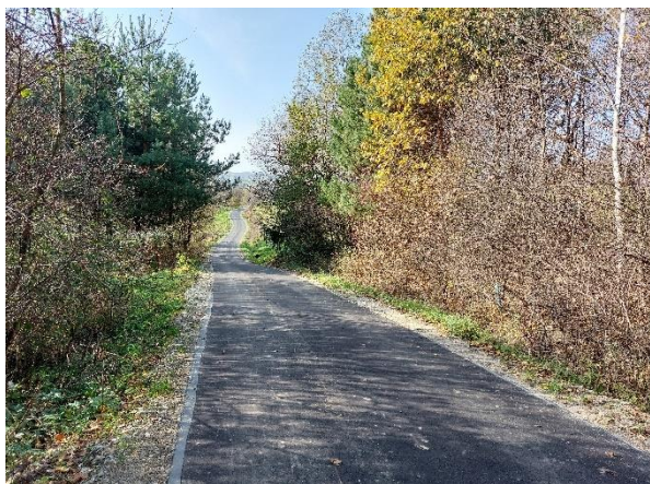
Nowa nawierzchnia w Wojkówce
