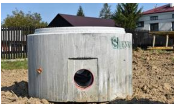
Budowa kanalizacji sanitarnej w Łękach Strzyżowskich
