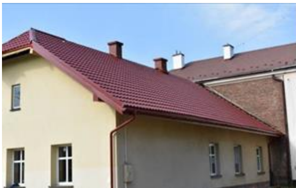
Remont dachu na przedszkolu w Łękach Strzyżowskich
