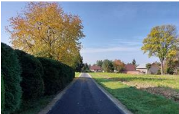
Droga w kierunku Wisłoka w Bratkówce
