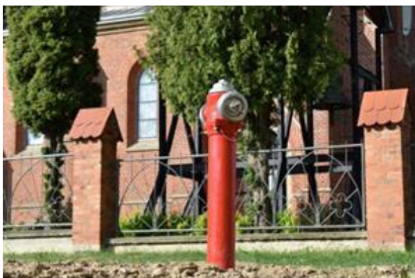
Budowa wodociągu w Odrzykoniu
