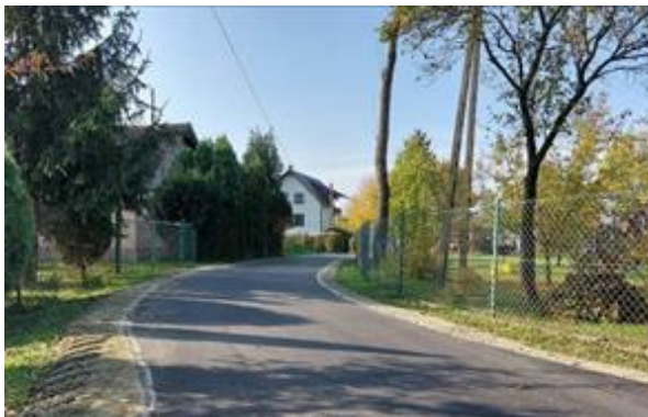
Droga w kierunku Wisłoka w Bratkówce
