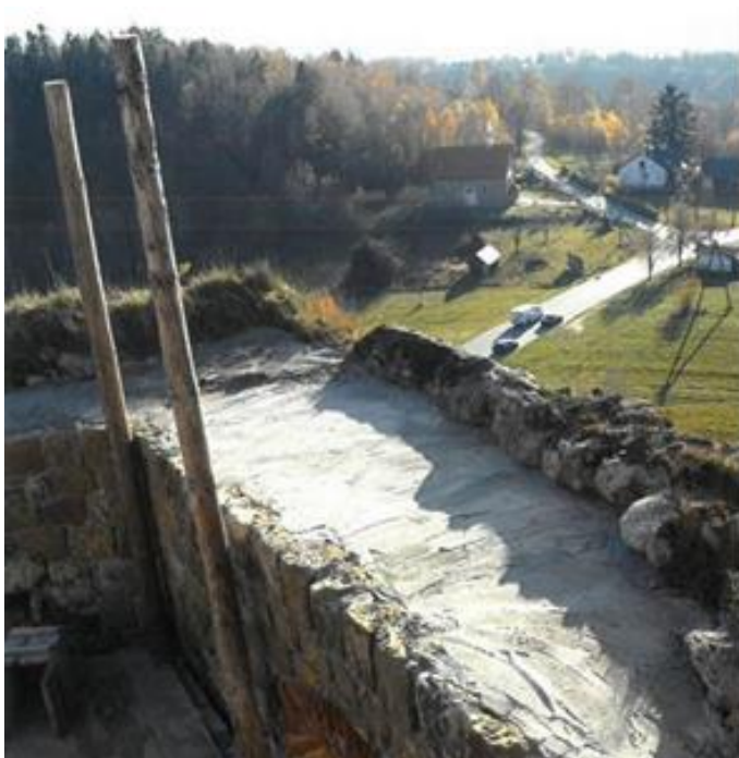
Zamek Kamieniec w trakcie prac konserwatorskich
