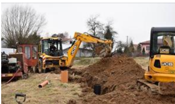
Budowa kanalizacji sanitarnej w Przybówce
