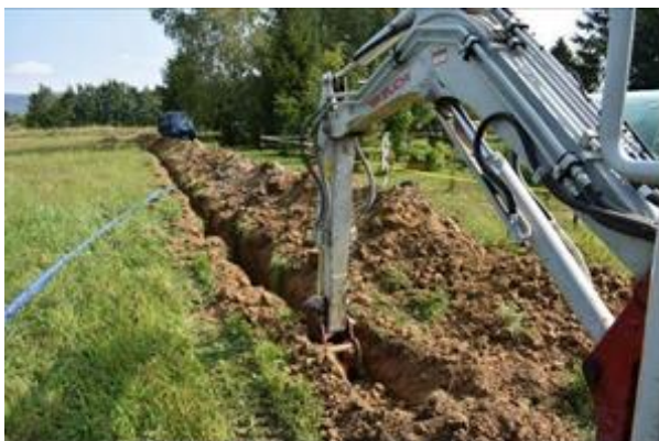
Budowa wodociągu w Odrzykoniu
