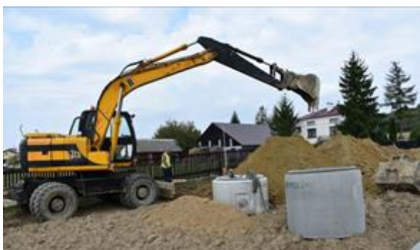
Budowa kanalizacji sanitarnej w Łękach Strzyżowskich
