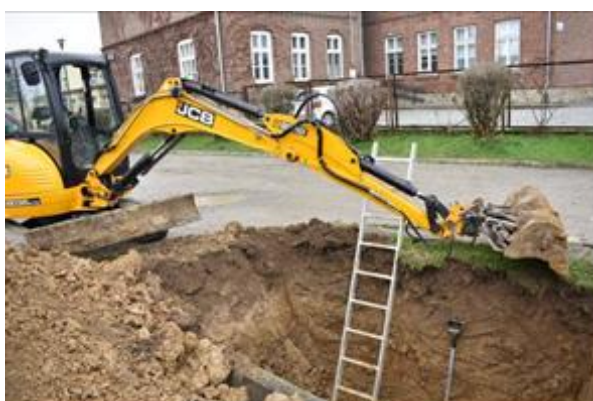
Budowa wodociągu w Odrzykoniu
