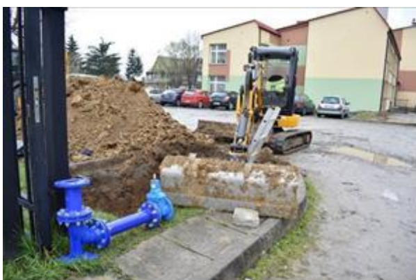
Budowa wodociągu w Odrzykoniu
