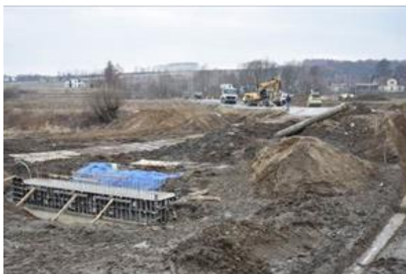
Pierwszy etap budowy mostu w Łękach Strzyżowskich
