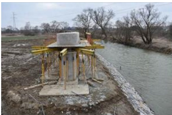
Pierwszy etap budowy mostu w Łękach Strzyżowskich
