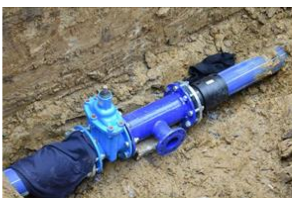
Budowa wodociągu w Odrzykoniu
