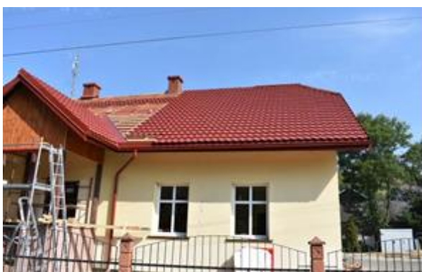
Remont dachu na przedszkolu w Łękach Strzyżowskich
