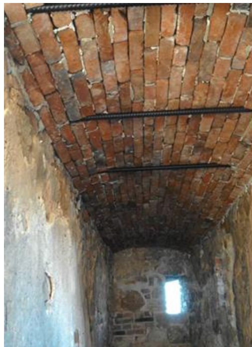
Zamek Kamieniec w trakcie prac konserwatorskich
