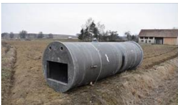
Budowa kanalizacji sanitarnej w Przybówce
