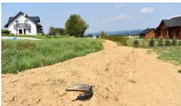
Budowa kanalizacji sanitarnej w Ustrobnej
