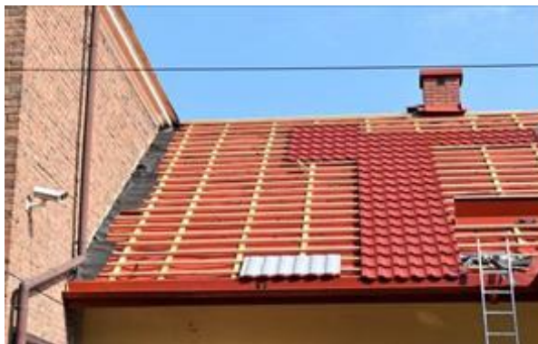
Remont dachu na przedszkolu w Łękach Strzyżowskich
