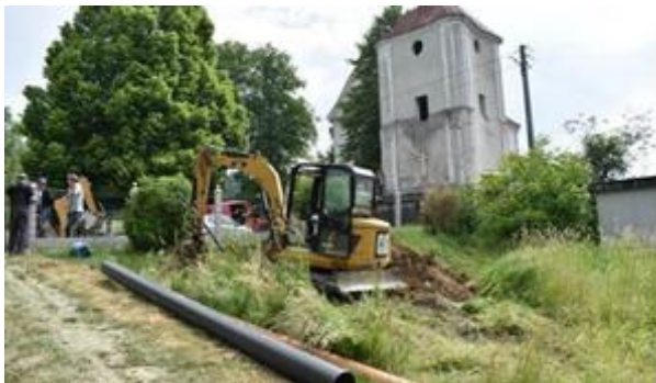
Budowa kanalizacji sanitarnej w Łączkach Jagiellońskich
