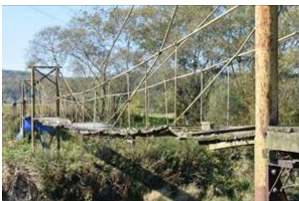
Rozpoczęcie budowy mostu w Łękach Strzyżowskich
