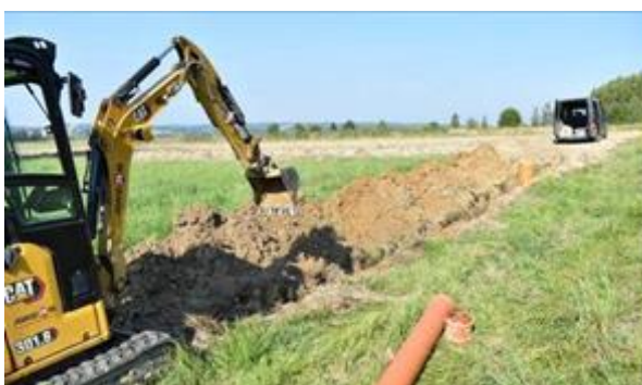
Budowa kanalizacji sanitarnej w Łączkach Jagiellońskich
