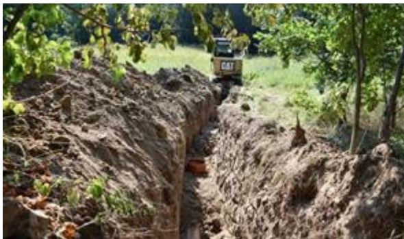
Budowa kanalizacji sanitarnej w Łączkach Jagiellońskich
