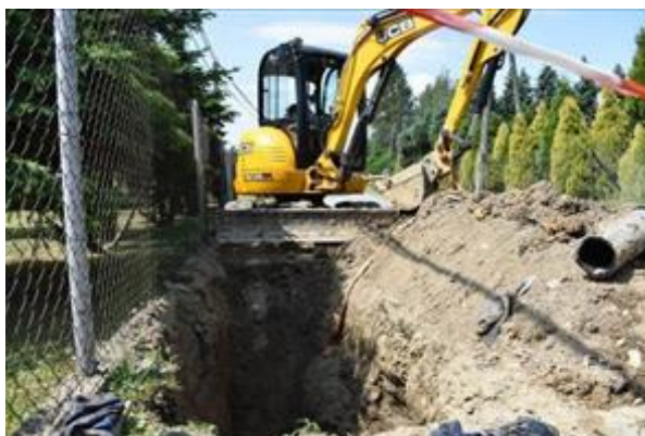
Budowa wodociągu w Odrzykoniu
