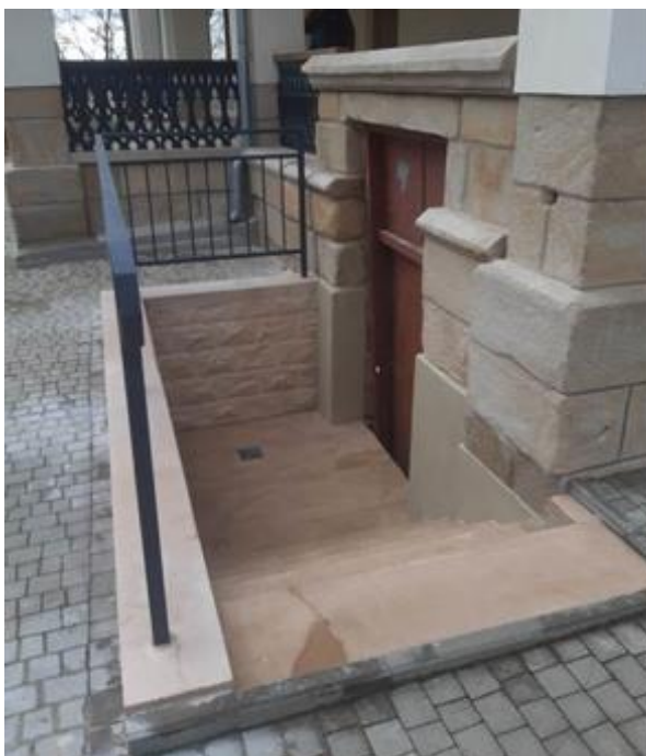
Dwór w Bratkówce po pracach konserwatorskich
