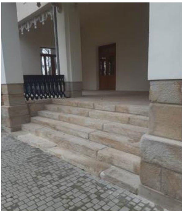
Dwór w Bratkówce po pracach konserwatorskich
