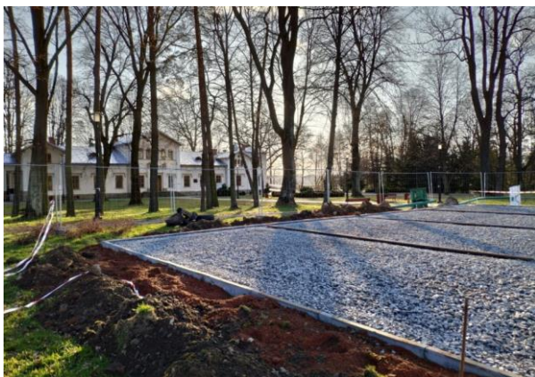
Boisko w Bratkówce w trakcie przebudowy
