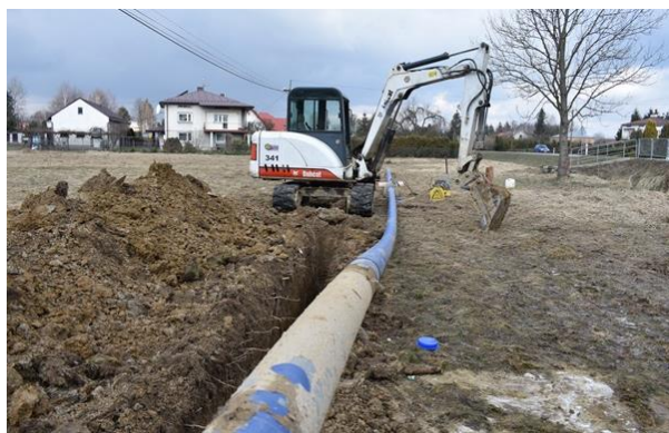
Budowa wodociągu Krosno - Odrzykoń - Ustrobnia - Bajdy
