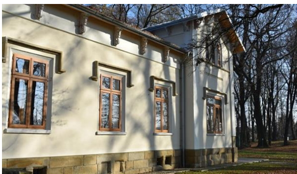
Dwór w Bratkówce po pracach konserwatorskich
