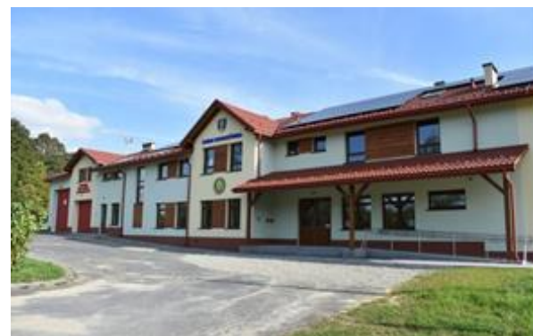
CEP w Pietruszej Woli po rozbudowie
