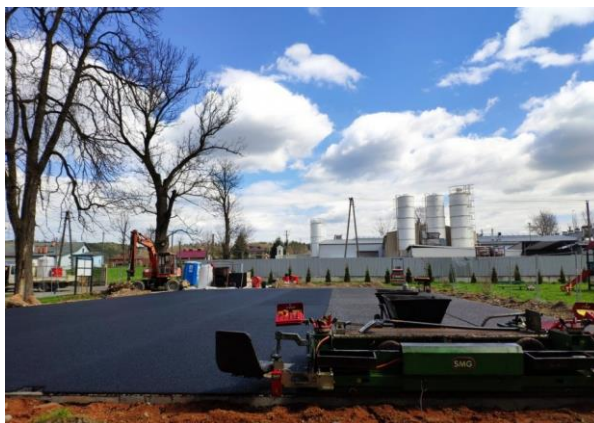
Boisko w Bratkówce w trakcie przebudowy
