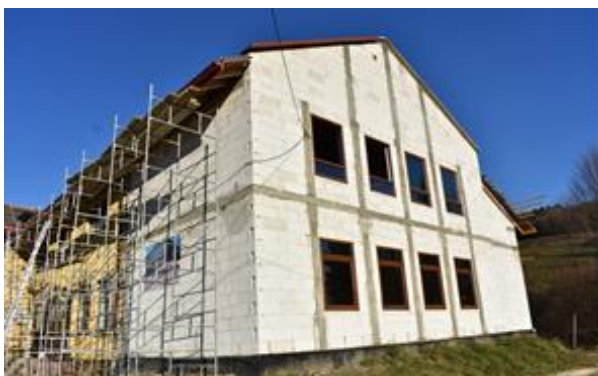
Rozbudowa CEP w Pietruszej Woli
