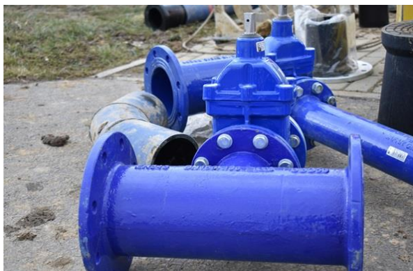
Budowa wodociągu Krosno - Odrzykoń - Ustrobnia - Bajdy
