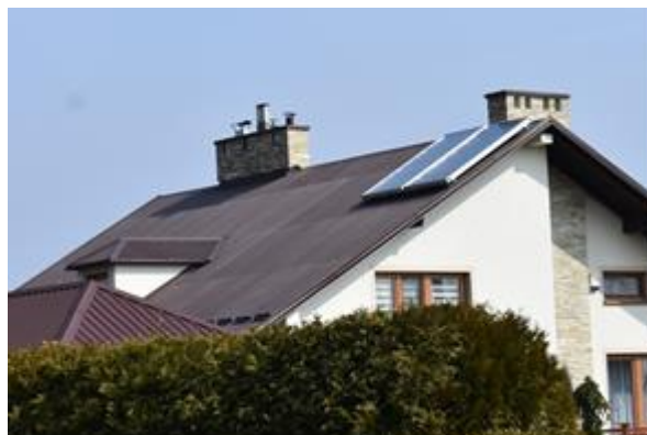
Instalacja solarna w gminie Wojaszówka
