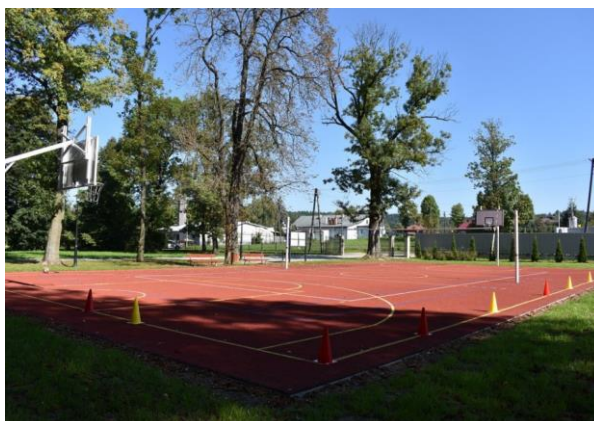
Boisko w Bratkówce po przebudowie
