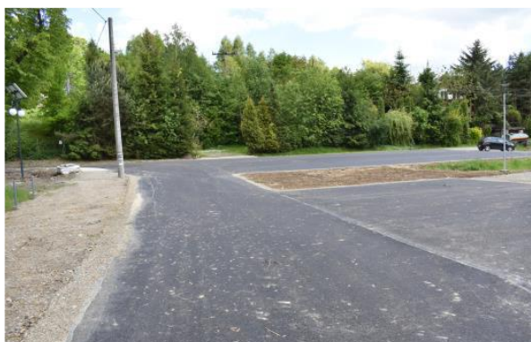
Przebudowana droga „do przedszkola”
