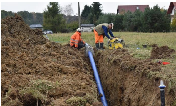
Budowa wodociągu z Krosna do Bajd
