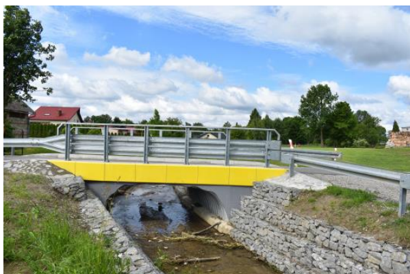
Wyremontowany przepust – ul. Wł. Jagiełły w Odrzykoniu
