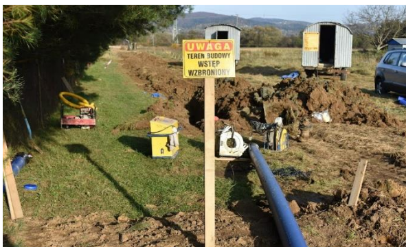
Budowa wodociągu z Krosna do Bajd
