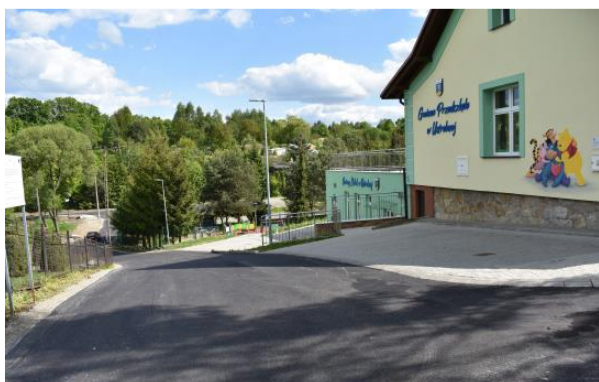
Przebudowana droga „do przedszkola”
