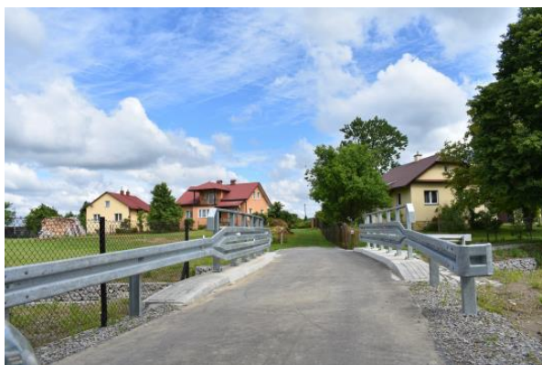
Wyremontowany przepust – ul. Wł. Jagiełły w Odrzykoniu
