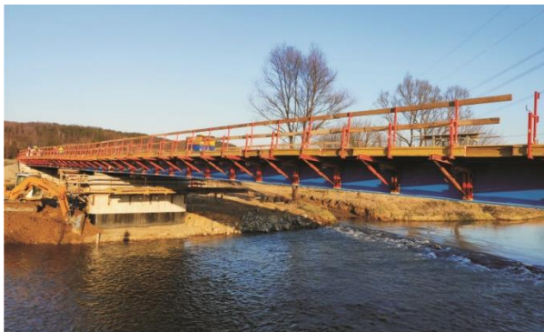
Most w Wojkówce w trakcie budowy
