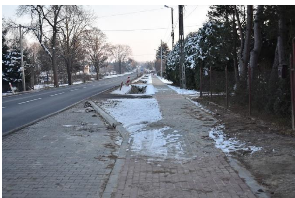
Kolejny chodnik w Ustrobniej
