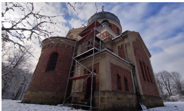
Cerkiew w Rzepniku w trakcie remontu
