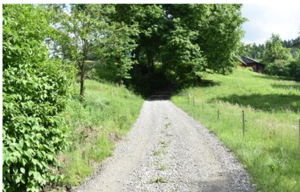
Przebudowana ul. Rzeki
