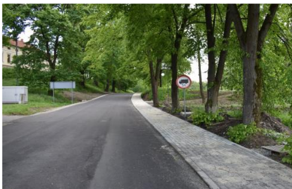
Przebudowana droga i nowy chodnik w Ustrobniej
